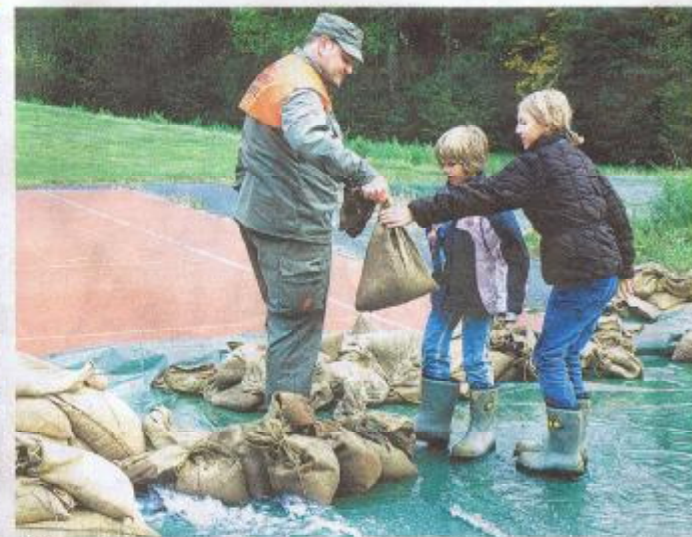
Mit Sandsäcken wird der «Hochwasserstrom» umgeleitet.
